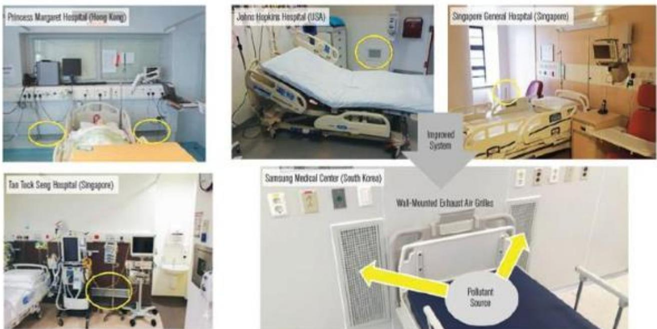
Figura 1 - Configuração de Grelhas de Retorno em Hospitais (Fonte: ASHRAE 2019)
